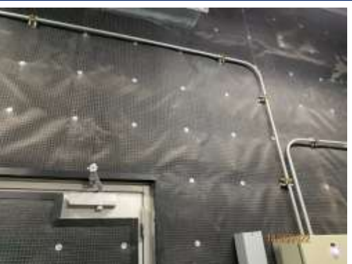
รูปที่ 3-43 ฉนวนกันเสียงของห้องเครื่องกำเนิดไฟฟ้าสำรองฉุกเฉิน (Generator)
