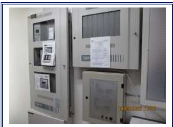
รูปที่ 3-53 แผงควบคุม (Fire Alarm Control Panel : FCP)
