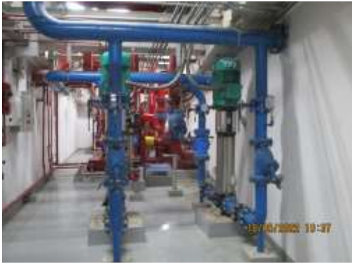
รูปที่ 3-26 ระบบสูบน้ำในอาคาร
