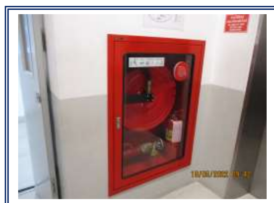
รูปที่ 3-50 ตู้เก็บสายฉีดน้ำดับเพลิงพร้อมอุปกรณ์ (Fire Hose Cabinet : FHC)
