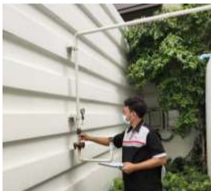
รูปที่ 3 -20 เจ้าหน้าที่ตรวจสอบระบบวาล์วเปิด-ปิด ของถังเก็บก๊าซมีเทน
