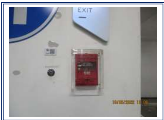
รูปที่ 3-56 เครื่องแจ้งเหตุโดยใช้มือตึง (Fire Alarm Manual Station)
