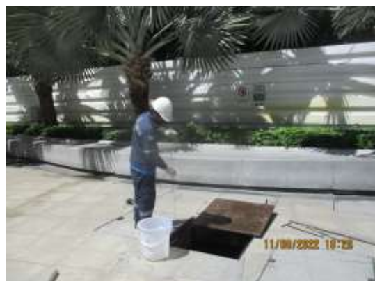
รูปที่ 4-28 การเก็บตัวอย่างคุณภาพน้ำทิ้ง บริเวณน้ำทิ้งหลังการบำบัด (บ่อสูบน้ำใส) เก็บตัวอย่างในวันที่ 11 มิถุนายน 2565
