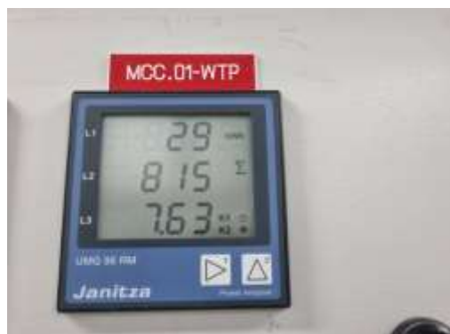
รูปที่ 3-19 มิเตอร์ไฟฟ้าสำหรับบำบัดน้ำเสียโดยเฉพาะ
