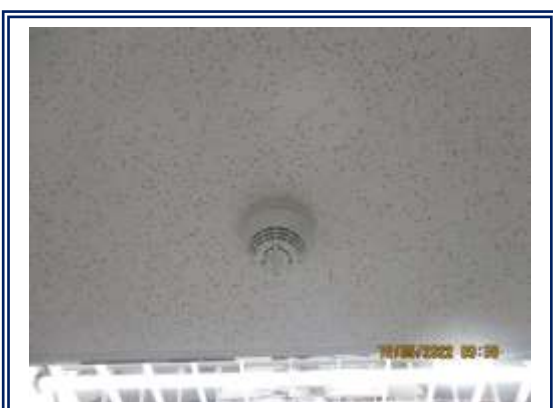
รูปที่ 3-54 เครื่องตรวจจับควัน (Smoke Detector)
