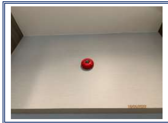
รูปที่ 3-57 กริ่งสัญญาณเตือนอัคคีภัย (Alarm Bell)
