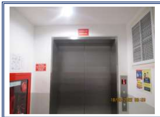
รูปที่ 3-52 ลิฟต์ดับเพลิง
