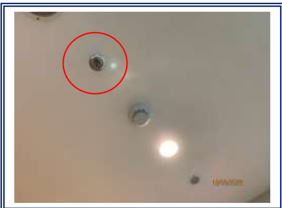
รูปที่ 3-51 ระบบหัวกระจายน้ำดับเพลิง (Sprinkler System)
