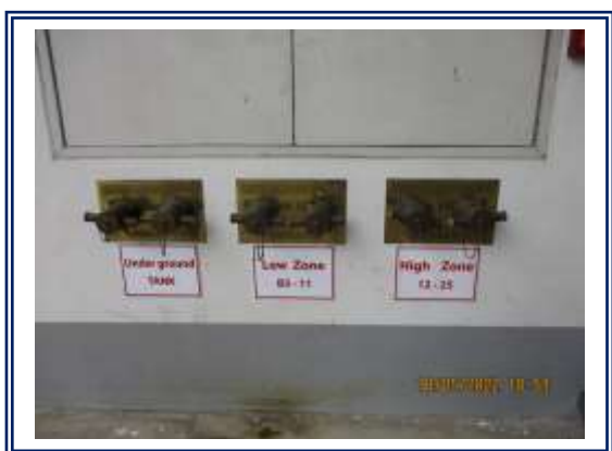
รูปที่ 3-49 หัวรับน้ำดับเพลิงภายนอกอาคาร (Fire Department Connector : FDC)
