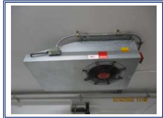
รูปที่ 3-9 พัดลมระบายอากาศบริเวณที่จอดรถชั้นใต้ดิน
