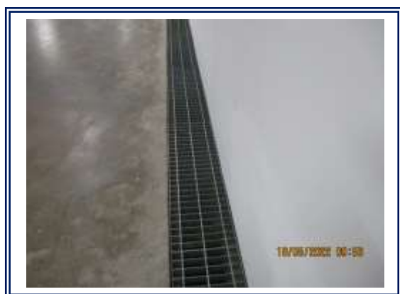
รูปที่ 3-32 รางระบายน้ำชั้นใต้ดิน
