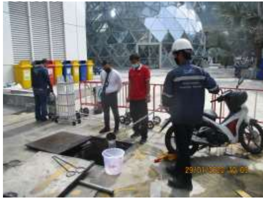
รูปที่ 4-17 การเก็บตัวอย่างคุณภาพน้ำทิ้ง บริเวณน้ำทิ้งก่อนการบำบัด (ถังแยกตะกอน) เก็บตัวอย่างในวันที่ 29 มกราคม 2565
