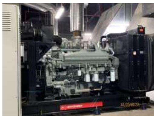
รูปที่ 3-42 เครื่องกำเนิดไฟฟ้าสำรองฉุกเฉิน (Generator)
