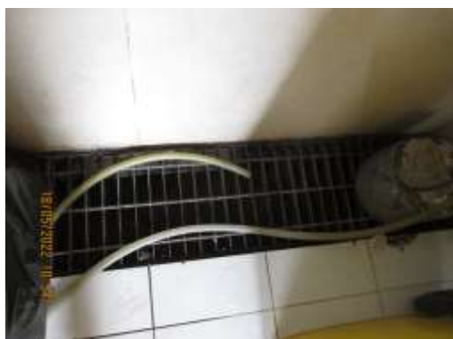
รูปที่ 3-39 ท่อรวบรวมน้ำล้างของห้องพักมูลฝอยของโครงการ
